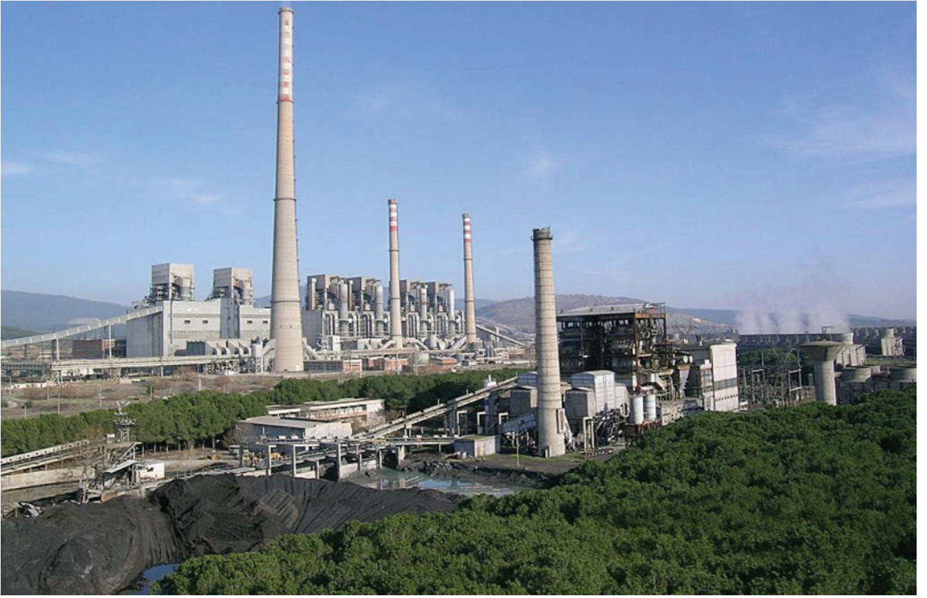
Şekil 5: Soma Termik Santrali
